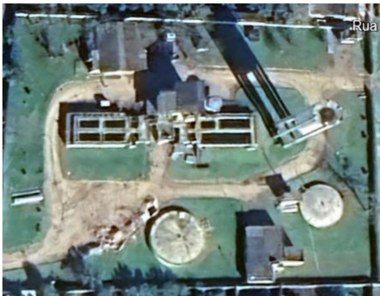
Figura 85 – ETA de Pedro Osório.
