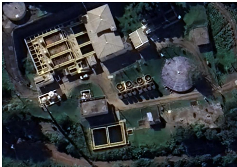
Figura 95 – ETA de Três Coroas.
