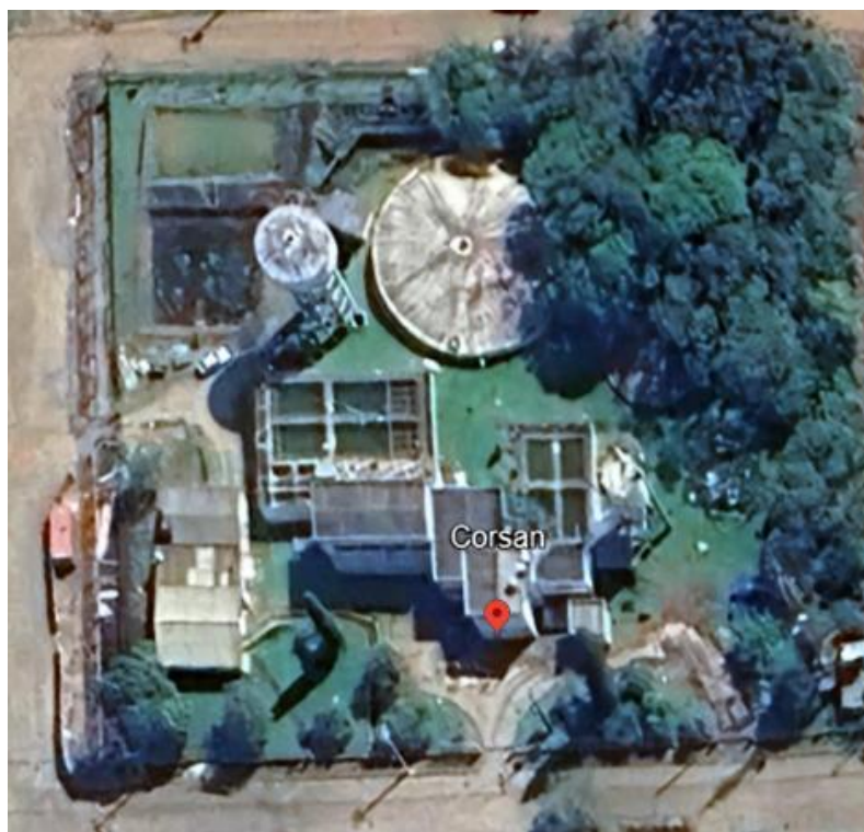
Figura 106 – Vista superior ETA Veranópolis.
