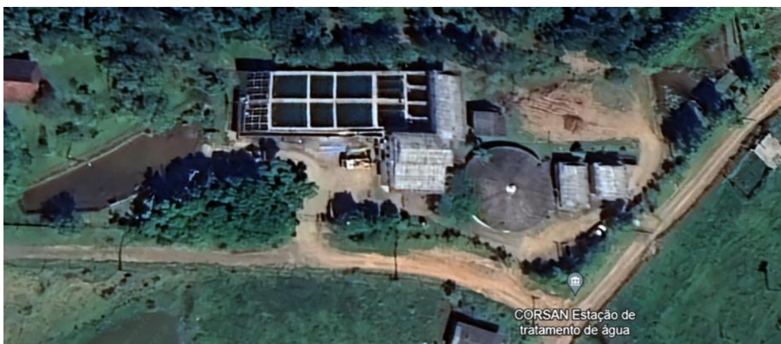
Figura 99 – Vista superior – ETA de Parobé.
