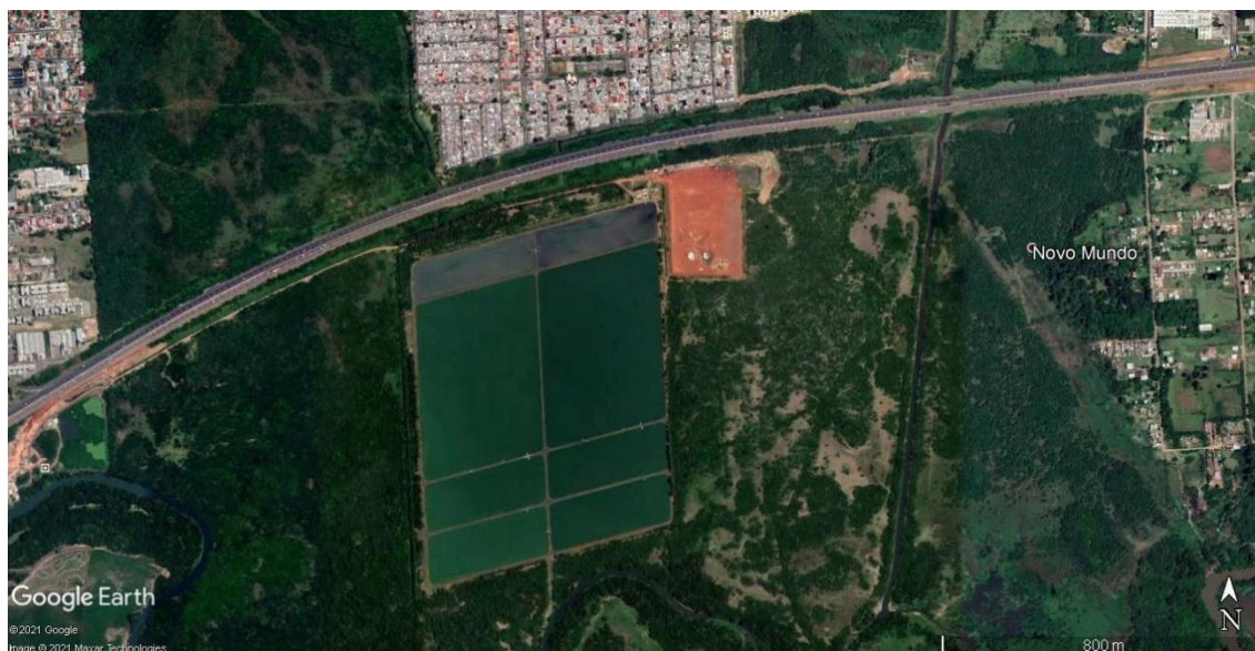
Figura 121 – Vista da ETE Freeway.
