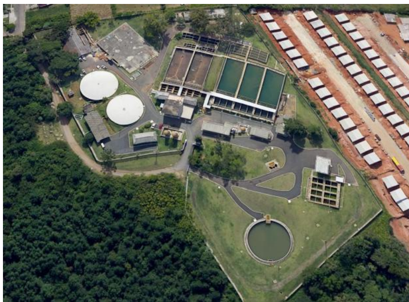
Figura 78 – ETA Campo Bom.
