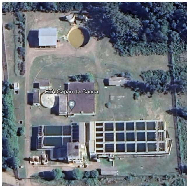
Figura 83 – ETA 2 de Capão da Canoa.
