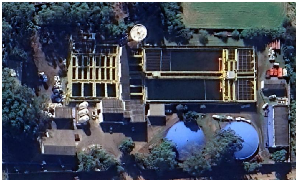
Figura 70 – Vista aérea da ETA Alvorada.
