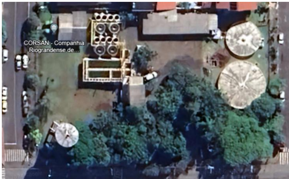
Figura 90 – Vista superior da ETA Dois Irmãos.
